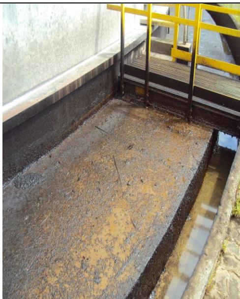
Fotos 38 e 39: Equipamentos apresentando vazamentos de hidrocarbonetos
