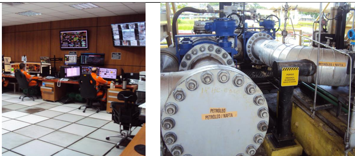
Fotos 13 e 14: Painel que opera na sala de controle / equipamentos que opera na área
