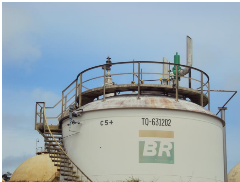
Fotos 15: Foto do tanque TQ-631202 de Nafta (com benzeno e tolueno) com PSV para atmosfera
