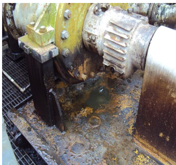
Fotos 60 e 61: Área do PPEOB (benzeno) / Vazamento nos equipamentos
