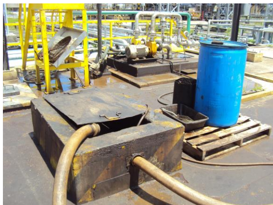
Fotos 58 e 59: Caixa API aberta com benzeno / Drenagem de equipamentos com benzeno para atmosfera
