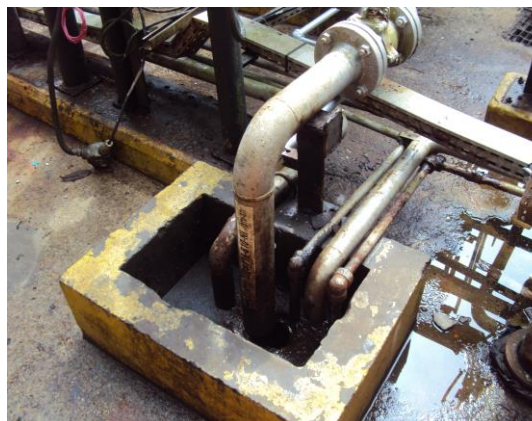
Fotos 58 e 59: Caixa API aberta com benzeno / Drenagem de equipamentos com benzeno para atmosfera
